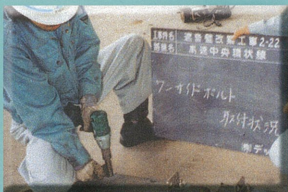
高速道路遮音壁改築工事
