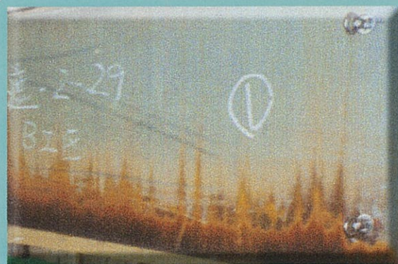
高速道路遮音壁改築工事
