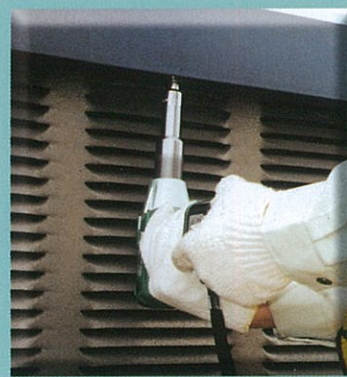
高速道路笠木改良工事
